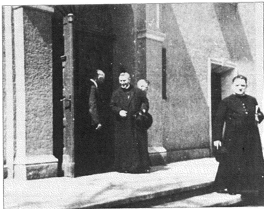
Wyjście z zboru ewangelickiego w Dziadowie
